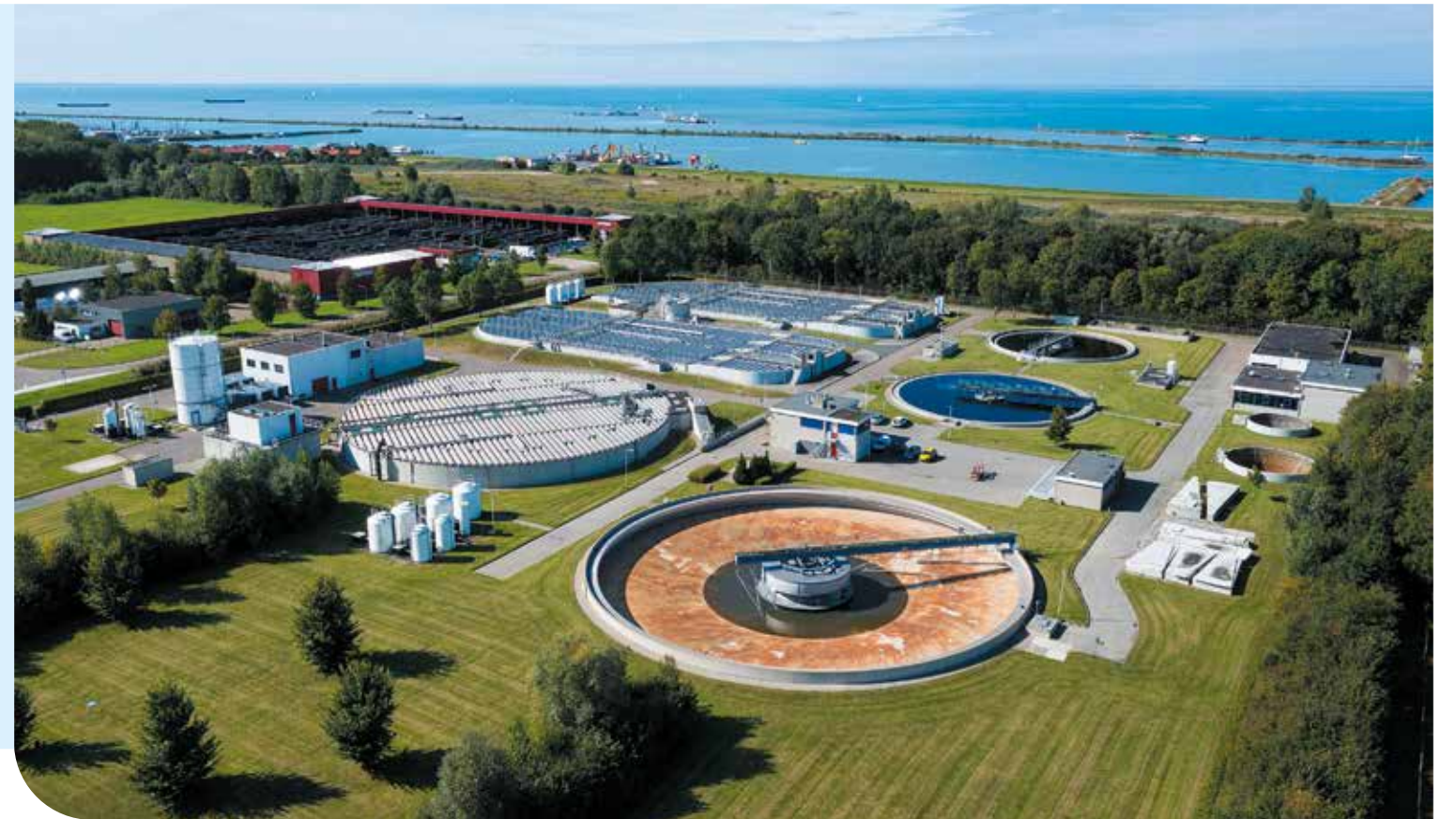
➤ Rioolwaterzuivering in Lelystad, een hotspot voor PFAS.
