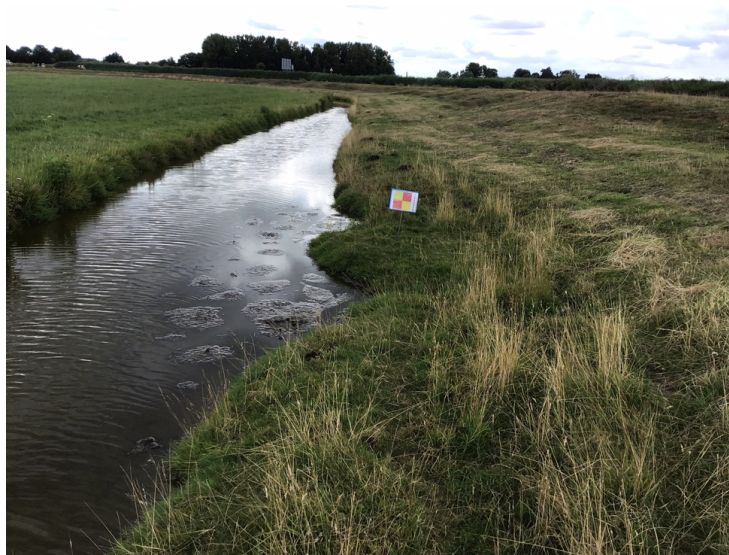
VERVORMING DOOR HET OPDRIJVEN VAN BAGGER BIJ HET HOOGHEEMRAADSCHAP HOLLANDS NOORDERKWARTIER
