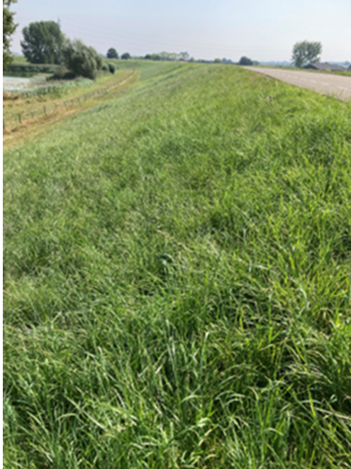
ZUIDTALUD GEMAaid IN MEI, WATERSCHAP RIVIERENLAND
