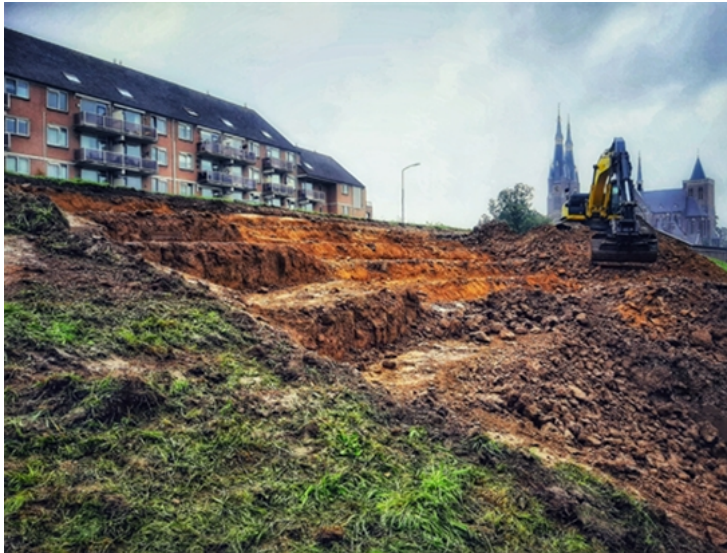
DIJKHERSTEL IN VERBAND MET SCHEUREN VAN EEN METER DIEP BIJ WATERSCHAP AA EN MAAS
