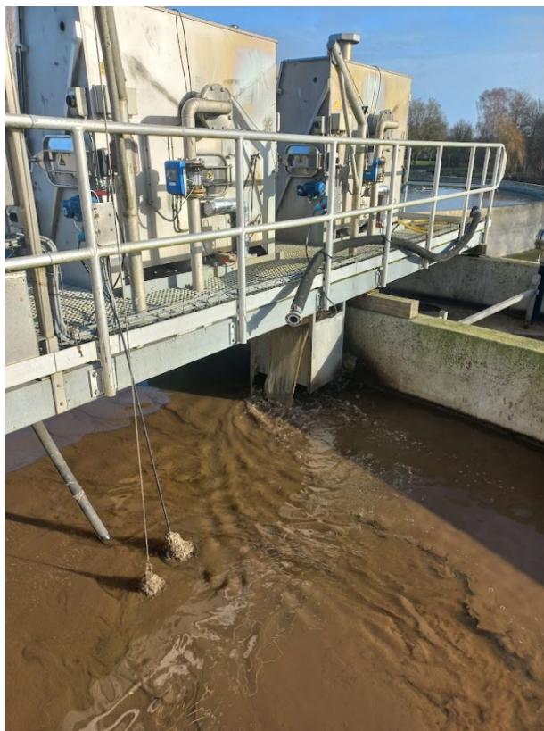
FIGUUR 7 ZEEFBOCHTINSTALLATIE OP ACTIEF SLIBTANK RWZI OMMEN. HET ACTIEF SLIB WORDT OVER TWEE ZEEFBOCHTEN GEFILTERD WAARBIJ VEZELS WORDEN AFGESCHIEDEN. ZIE OOK STOWA 2020-33
