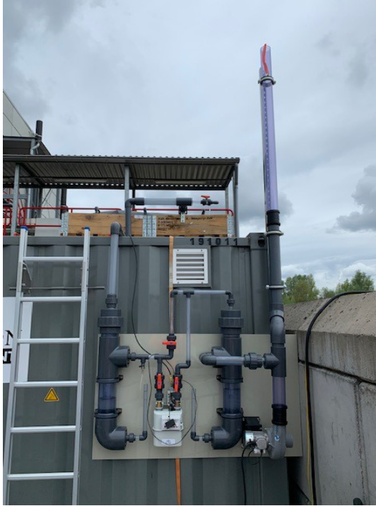
FIGUUR 9 REGISTRATIE VAN DE GASPRODUCTIE MET BEHULP VAN EEN GASKLOK, CONDENSOPVANG EN WATERSLOT
